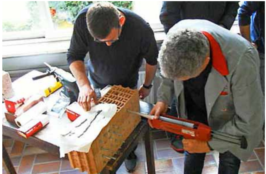
Abb. 2: Schüler Hermann Voth (l) mit dem Experten Weyda beim setzen eines Injektionsankers in einen Hochlochziegel
