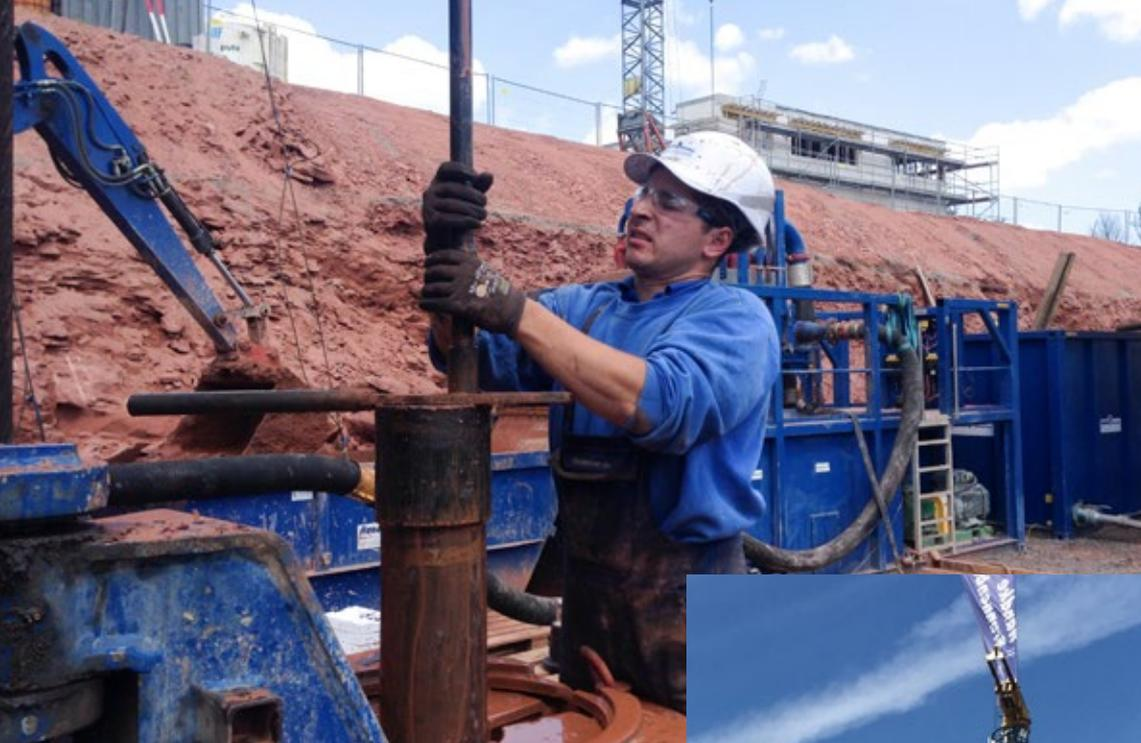
Aus Tiefen bis zu 1.500 Metern holt die Sonde bis zu 120 Grad heißes Wasser, mit dem direkt oder via Wärmepumpe Heizungen in Mehrfamilienhäusern, Wohn- und Industriekomplexen betrieben werden können.
